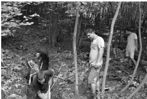
Výkop prístupovej cesty. Foto: M. Repaszský
