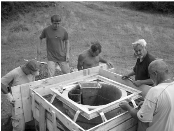
Rudolfsächta – betonáž uzáveru
