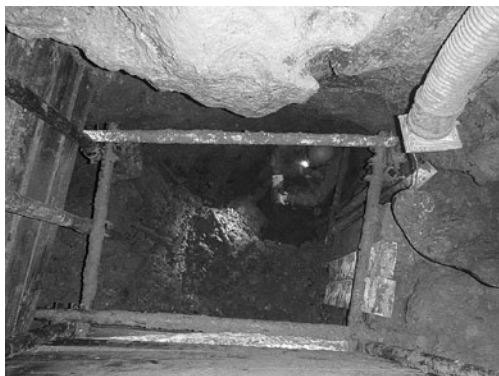
Najhlbšie dosiahnuté miesto v Orešanskej sonde po zabezpečení výdrevou
