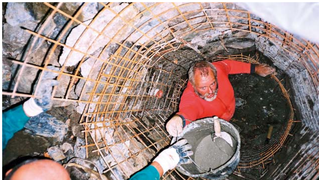
Obr. 6. T. Ďurka stabilizuje vstupnú šachtu betónovým obstrekom. Foto: P. Čarný
