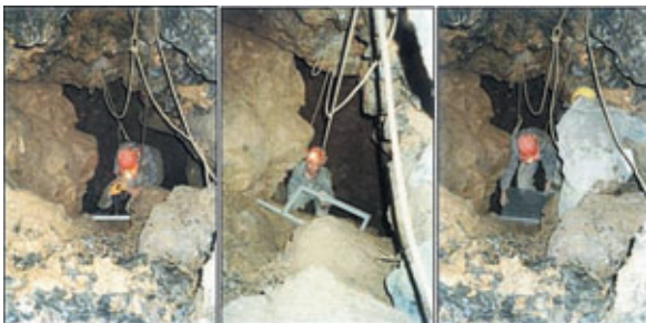
Montáž plošiny nad priepastou Olovko vo Večnej robote. Foto: E. Hipmanová
