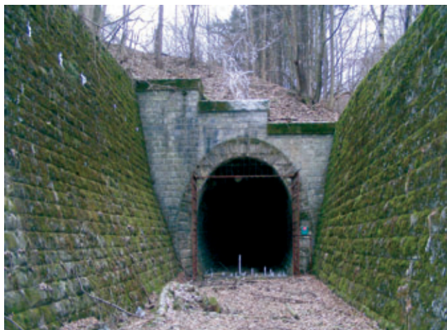
Vchod do tunela. Foto: D. Hutka
