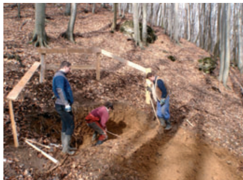
Výkopové práce. Foto: M. Zvonár
