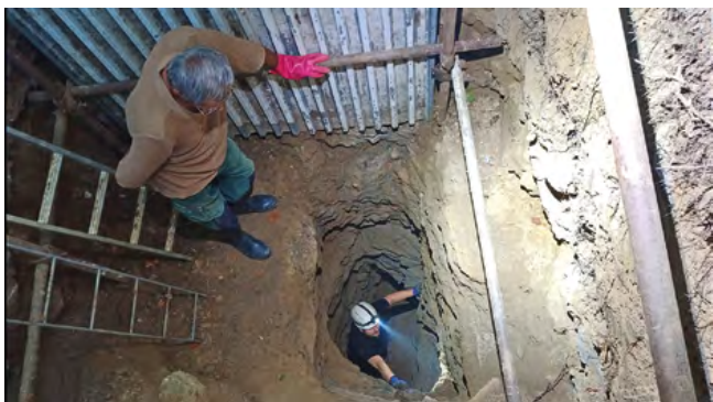
Práce na otváraní horného vchodu.
