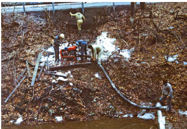
Spúšťanie čerpadla na čistenie Bahennej chodby v r. 1987.
