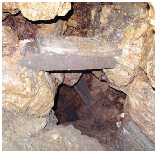
Betónovanie voľných blokov a hotový betónový preklad. Foto: J. Mikloš, Z. Hochmuth
