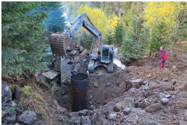
Osadenie ocelevej rúry do výkopu za pomoci bagra. Vedľa pyramída na staršej sonde.
