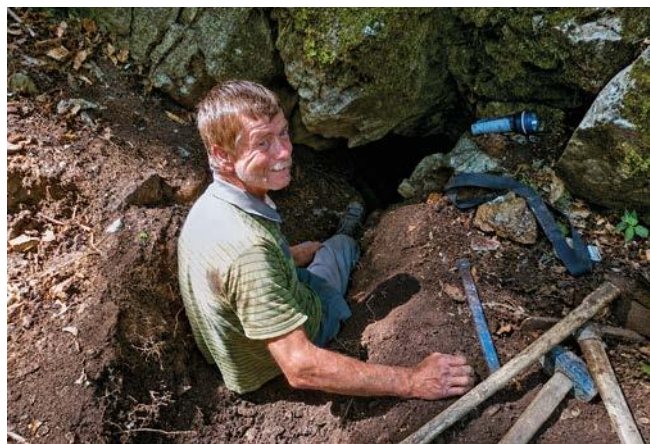
Obr. 14. Prvé výkopové práce v Čiernodolinkovej jaskyni v júli 2011 realizoval Peter Halenár. Foto: A. Lačný
