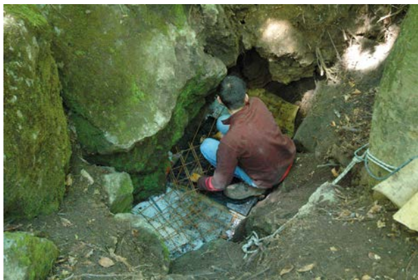
Obr. 8. Matej Zvonár pripravuje vchod do jaskyne na zaliatie betónom. Foto: A. Lačný
