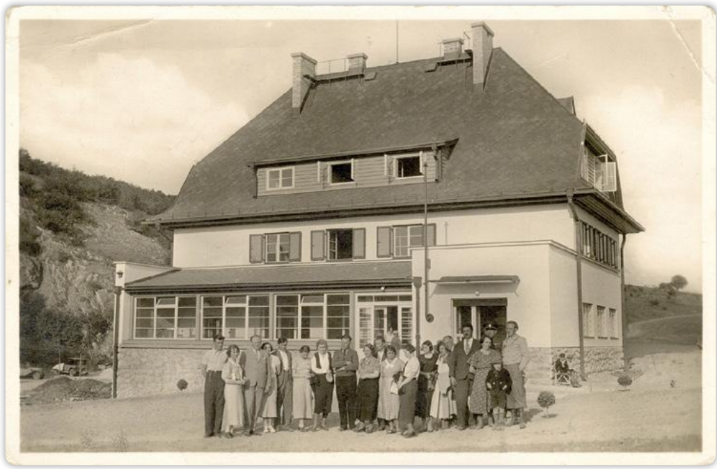
Budova KČST, projekt vypracoval architekt Hanuš z Prahy, stavbu realizovala firma Jozefa Šašinku z Popradu. Budova sa nachádzala asi 50 m od vchodu do jaskyne na ploche 300 m 2 . Vydal J. Chorvát, veľkoprodejca tabaku a papiernictvo z Tornale, vydavateľstvo pôsobilo v rokoch 1905 – 1945, pohľadnica.
