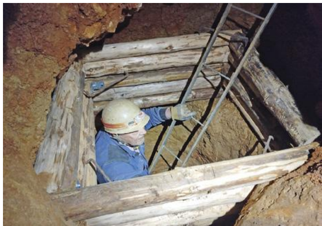
Ústie výdrevy vertikálneho úseku.
